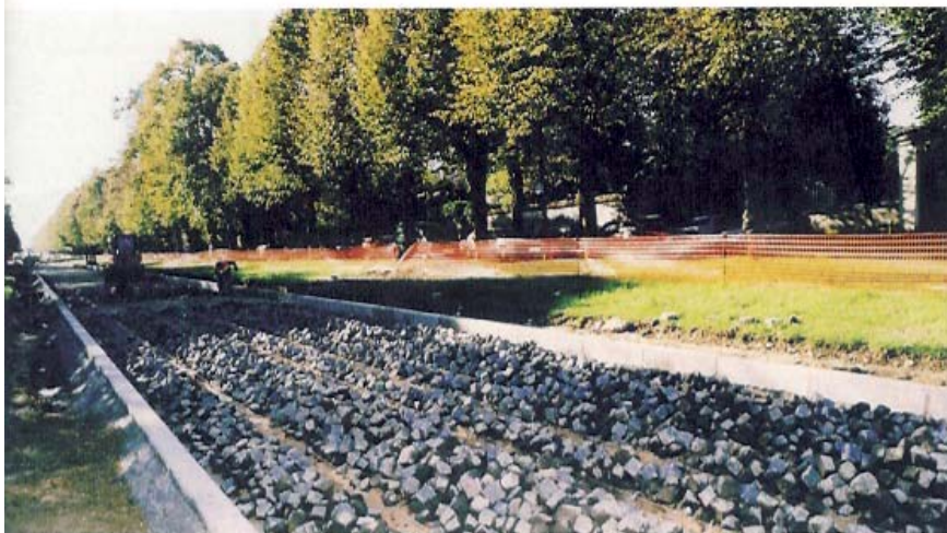
Après les travaux sur l'avenue du Château, viennent de démarrer la nouvelle phase qui concernent les aménagements des contre-allées.
